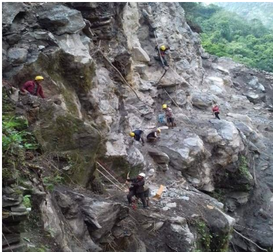
चित्र ५: देउराली क्षेत्रमा सतही सडक निर्माणको क्रममा ड्रिलिंग गरिएको दृश्य
