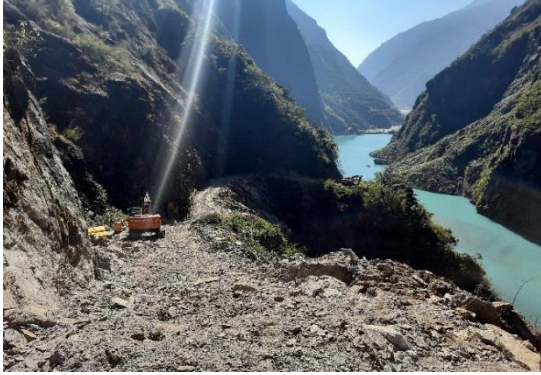
चित्र ३: सुरुङ्ग मार्गको आउटलेट पोर्टल देखि करिब १०० मिटर अगाडी निर्माण भइरहेको सतही सडकको दृश्य
