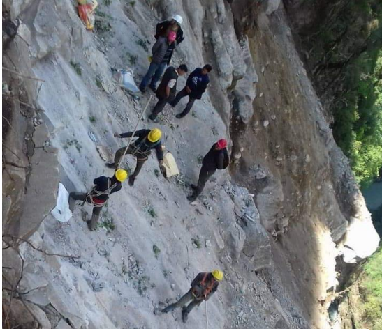
चित्र ७: सतही सडक निर्माणको क्रममा विस्फोटन गर्नका लागि तयारी गर्दै गरेको दृश्य
