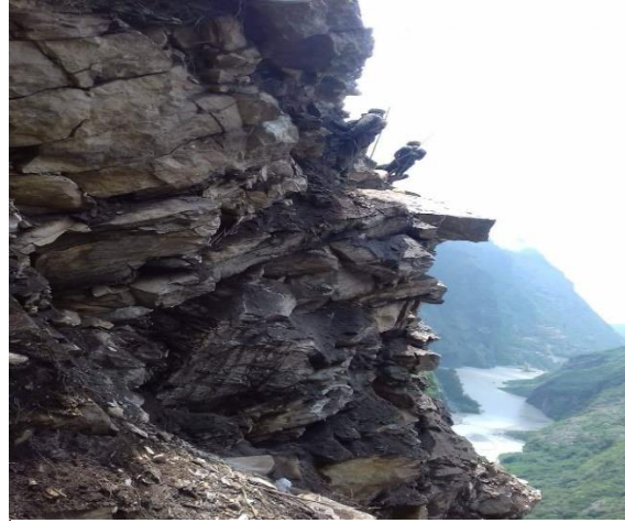
चित्र ८: सतही सडक निर्माण गर्ने क्रममा rock scaling गर्दै गरेको दृश्य
