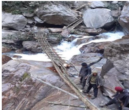
चित्र ९: पैदल मार्गको स्तरोन्नति तथा जुम र लप्ची दोभानमा बनाइएको अस्थायी पुल (फड्के)
